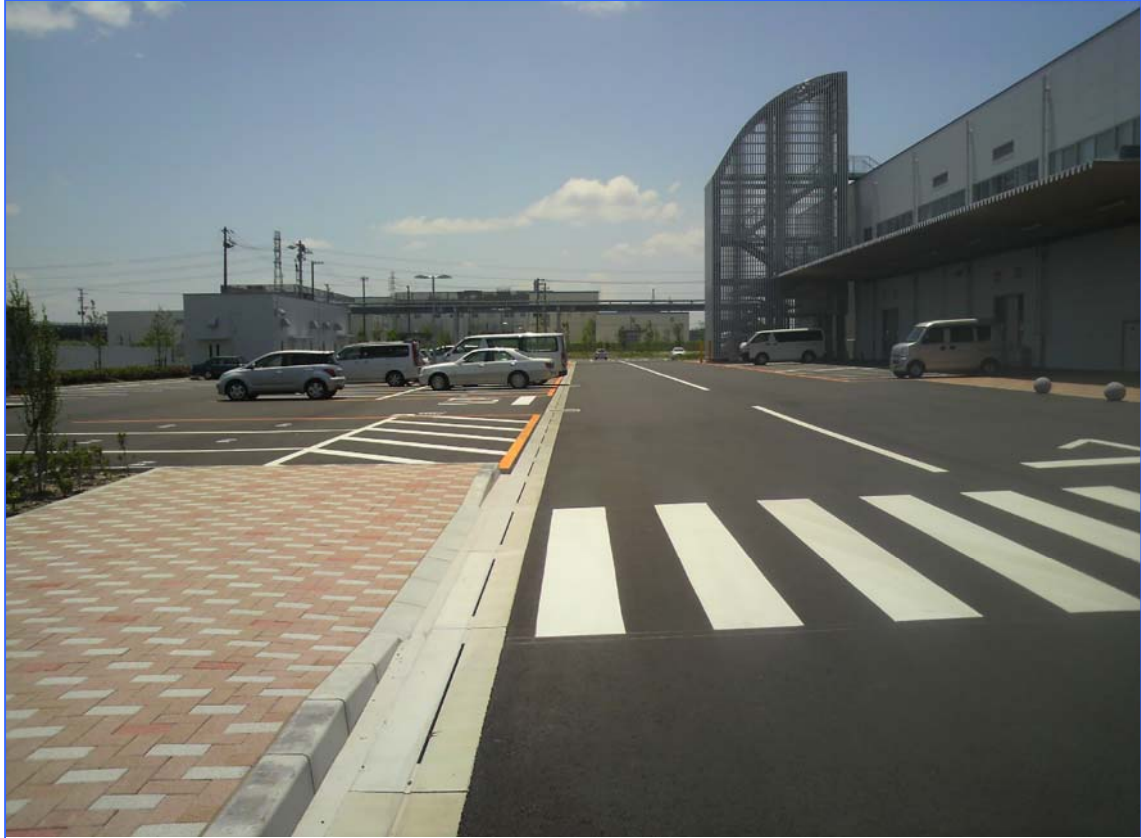
施工後現場風景①
