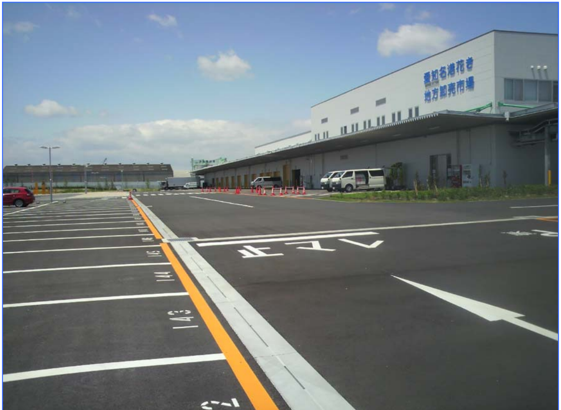
施工後現場風景②
