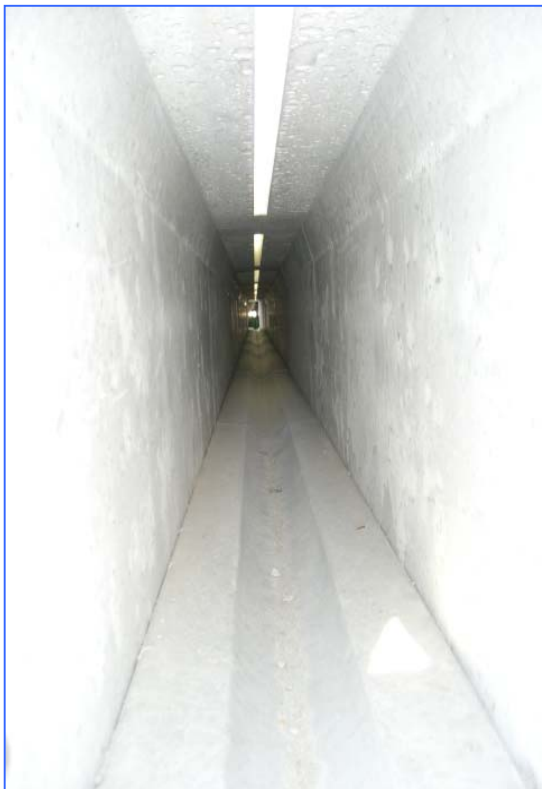
施工後側溝内部状況
