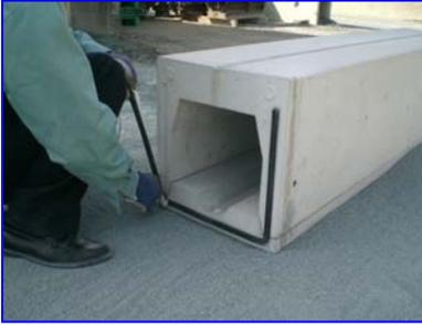
目地パッキン取付部分のゴミ、汚れを取り除く。パッキンのシールを剥がし本体に剥がれないようにしっかりと貼り付けて下さい。
