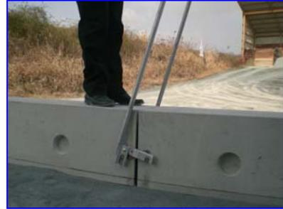
パワーハンドバーを握り手前にゆっくりと引き込んでいくと製品の間隙がなくなりPボルトにPプレートのU形穴が入りロックされる。
