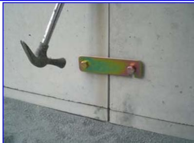
パワーハンドを取り外し、ハンマーを用いてPボルトの頭を交互に叩いて奥まで打ち込む。(取り外しは、スパナ等使用)
