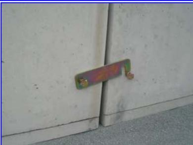
製品(右側)にPプレートの丸穴にPボルトを通しPボルトが止まるまで挿入する。引寄せする製品(左側)にPボルトを挿入しその上にPプレートを掛ける。
