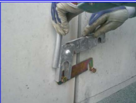
パワーハンドの固定側を丸穴側プレートとPボルトの間に入れ、下方向いっぱい差し込む。又移動側(引寄せする製品)も同様に差し込む。
