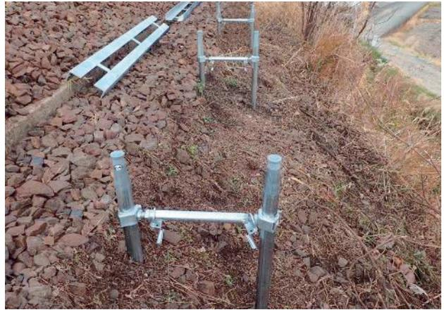
「従杭」を打ち込む際に「主杭」を基準にスパンを取りながら打込める施工治具がありますのでご相談下さい。受台の水平確認をお願いします。
