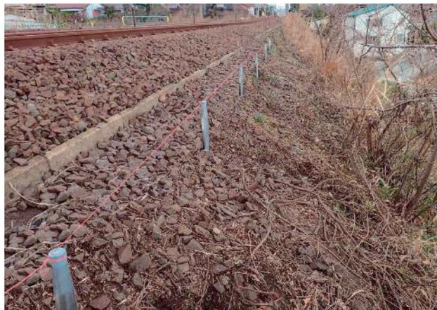
参考施工例: 始点と終点に杭を打込み、杭頭部で墨出しを行い、その線に沿って2m間隔で「主杭」を打ち込んで下さい。
