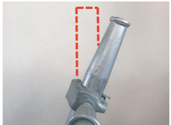
杭受台・アングルに対して杭が斜めになった場合でもクランプの接続部がボルトになっている杭の向きに合わせてクランプを回して固定する事で受台は水平、アングルは直線で設置をすることができます。
