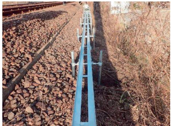
アンゲルの位置調整を行い、写真(左)の赤丸部のボルトを締め付け、アンゲルの固定をして下さい。
