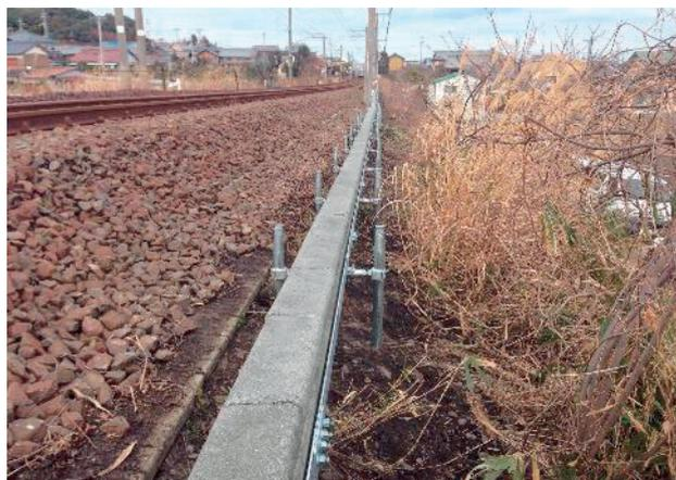
杭頭部へ防錆スプレーを吹きかけた後、赤キャップを付けて下さい。
