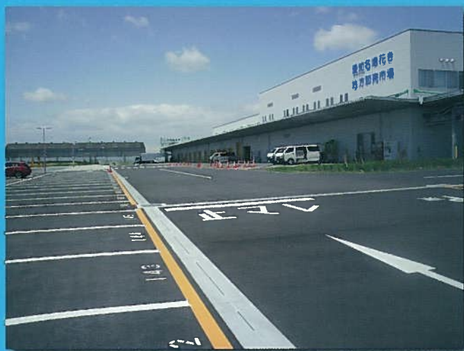
SE-Ki300×300~600 施工現場
